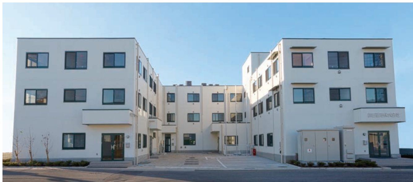
武蔵野営業所全景（埼玉県新座市）
