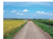
マイルドベースを施工した現場
