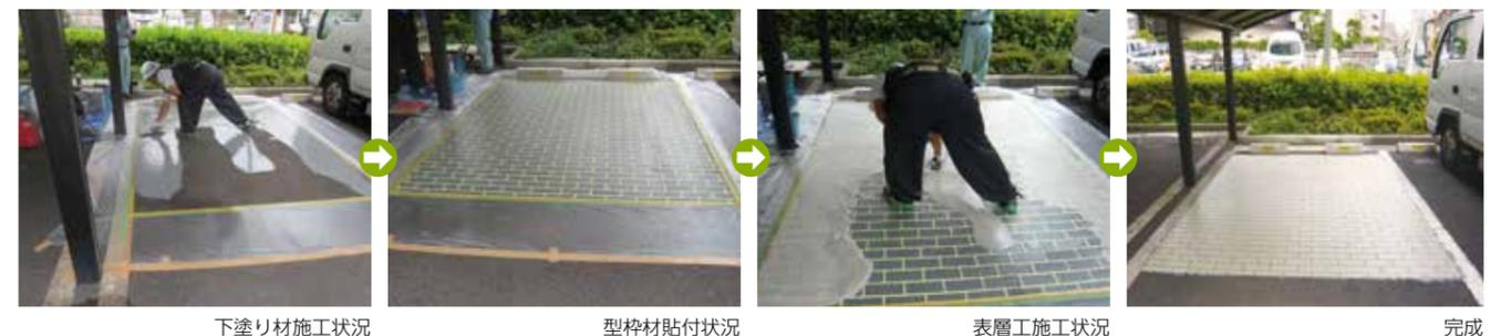
KC工法は、高級感あふれる床面にすることが可能な景観工法で、これまで東海道新幹線のプラットホーム改修工事などで施工させていただきました。プラットホームのような時間的制約を受ける現場にて、短時間での施工、早期開放が可能です。硬化までの間に発生する臭気が最大の問題でした。そのため、臭気が籠りやすい屋内コンコースや商業施設の改修工事に提案することができず、大変悔しい思いをしてきました。このたびは試行錯誤の上で低臭型KC工法が完成したことにより、これまで提案できなかった施工箇所への提案が可能となりました。今後はより多くの場所で皆様のお役に立つことができれば幸いです。
