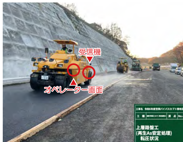
転圧管理システムを使った施工
