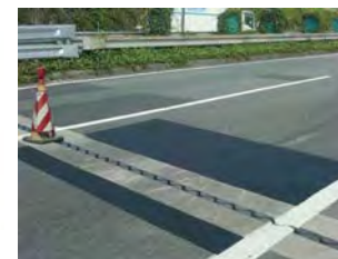
▲施工事例：ブラック ジョイント部やマンホール周りの段差修正
