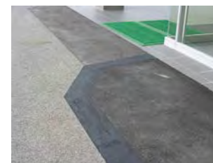
▲施工事例：ブラック すり付け合材の飛散防止
