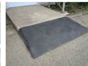
▲施工事例：ブラック バリアフリーの段差修正
