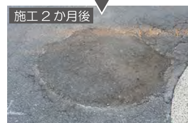
- 施工事例（ポットホールの補修） -
