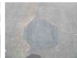
▲施工事例：ナチュラル（セメント色） 荒れた路面のリフレッシュ
