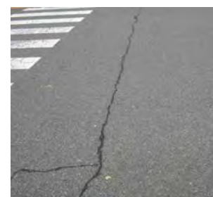
—クラック補修—
