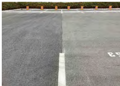
REAP 通常改質As -写真-1- REAPと通常改質Asの経年比較写真-
