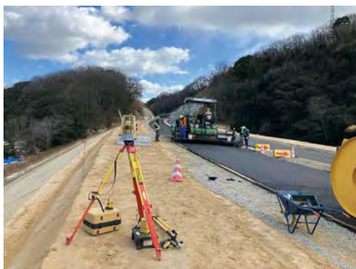
3D-MC アスファルトフィニッシャーによる施工
