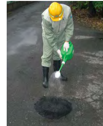
- 施工状況（散水） -
