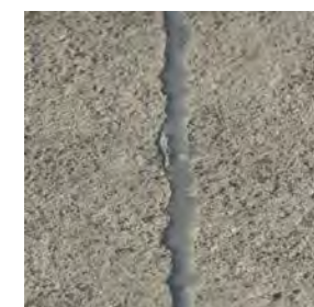
—コンクリート舗装の目地補修—
