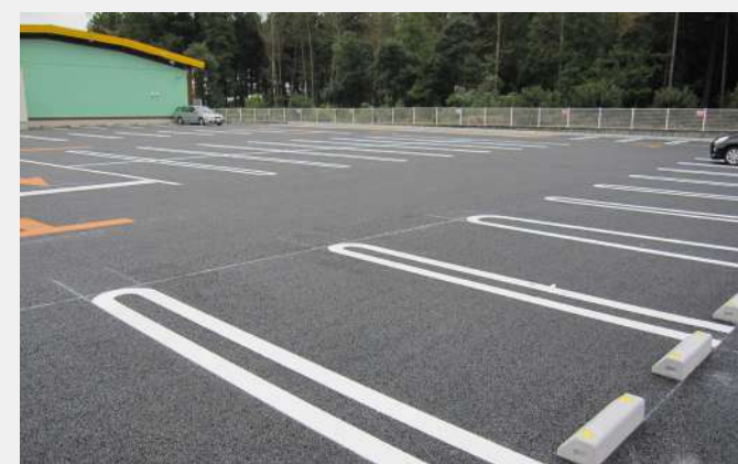
③ 2017年7月の大雨 完成後、同レベルでの豪雨でも冠水被害なし
