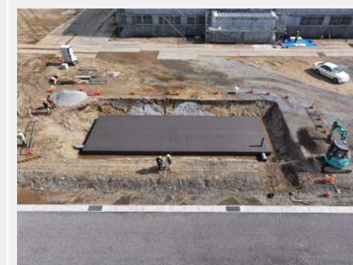
保護シート施工
