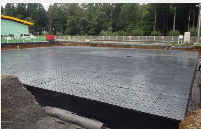
② 降雨モデルを根拠に設計 2014年の大雨でも冠水しない貯留量
