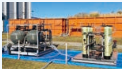
※2 PFAS 浄化装置設置状況
