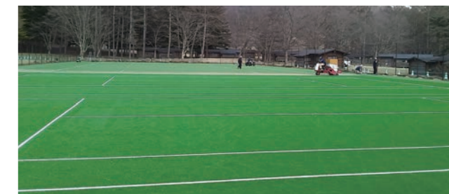
軽井沢プリンスホテルウエスト 構内テニスコート移設工事（長野県）
