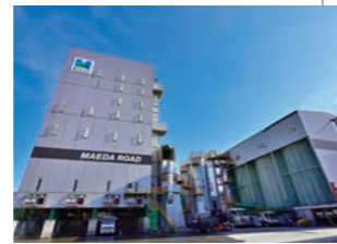
西東京合材工場（東京都）
