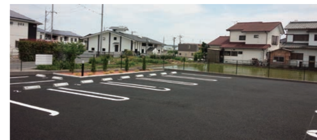
駐車場舗装工事
