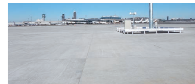
成田国際空港 T2 南側地区エプロン舗装工事（千葉県）
