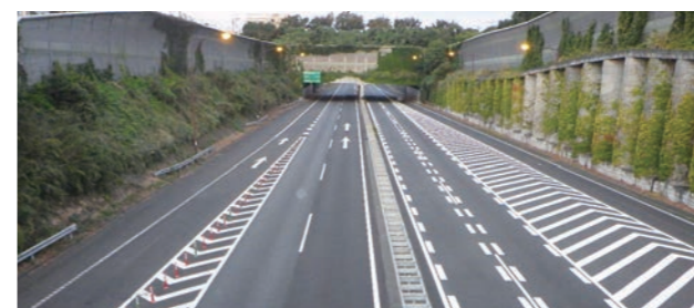
横浜新道 京浜管内舗装補修工事（神奈川県）
