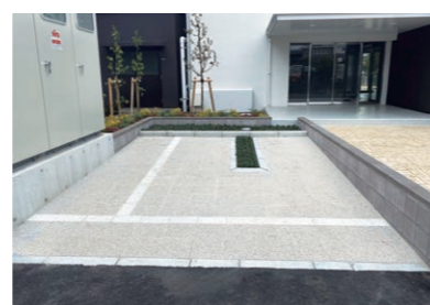
写真-3 無動力灌水装置と保水性ブロック
