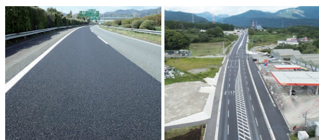
東名高速道路 富士管内 (静岡県) 国道57号 (熊本県)
