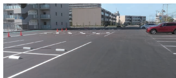
駐車場舗装工事
