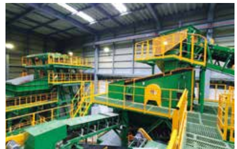
住之江破碎工場
