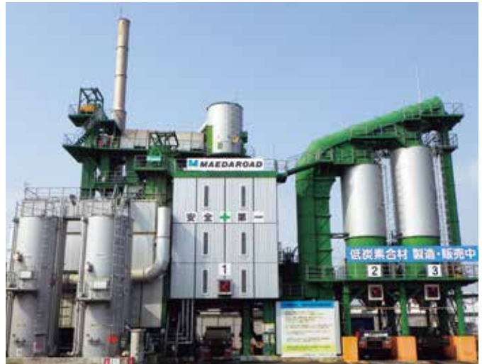
低炭素合材の製造・販売を行う広島合材工場
