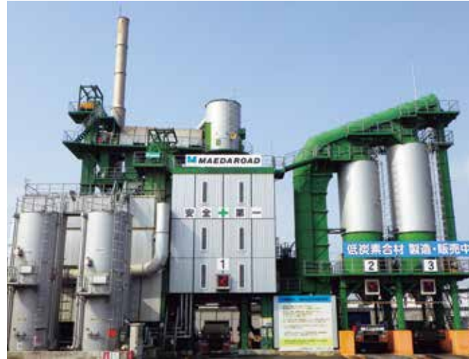
低炭素合材の製造・販売を行う広島合材工場
