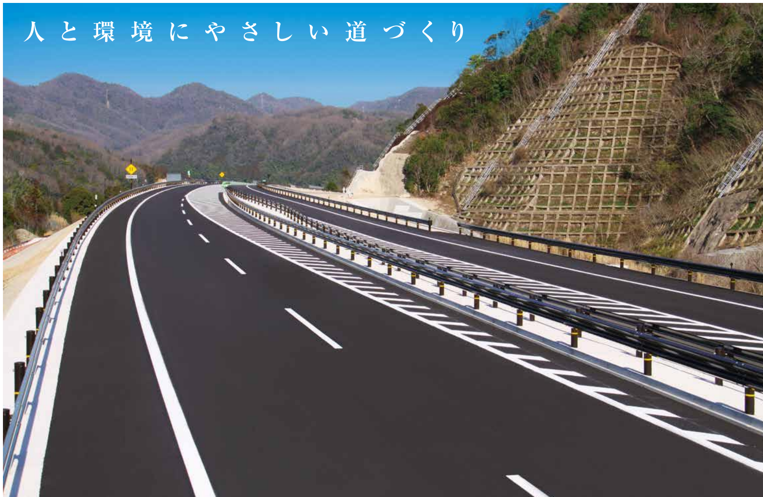
東広島バイパス瀬野西IC舗装工事
