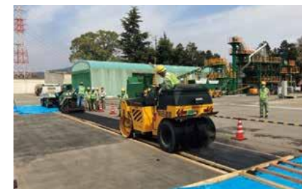
技術研究所での試験施工
