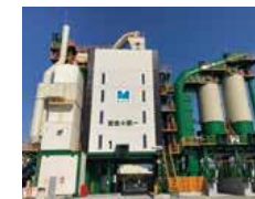
郡山合材工場
