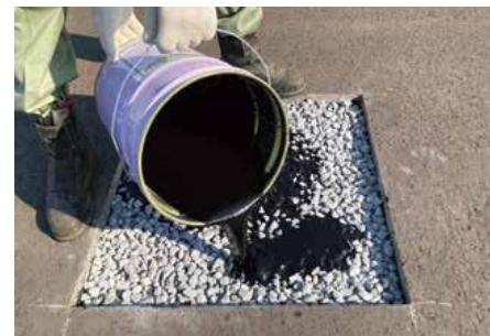
「マイルドグース」での施工
