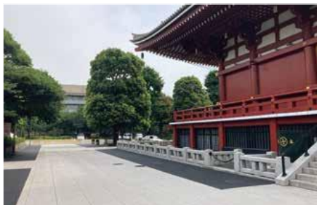
本堂西側の施工後
