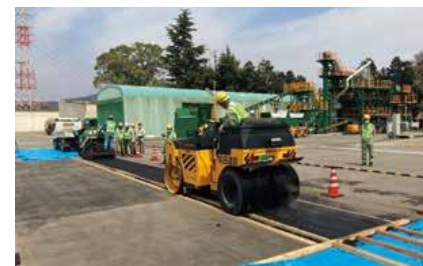
技術研究所での試験施工
