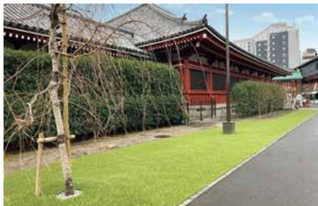
五重塔北側に敷いたロングパイル人工芝
