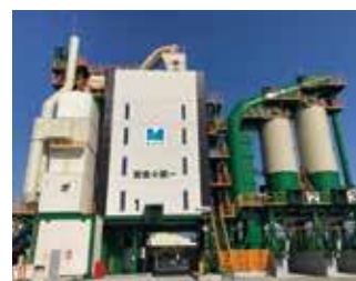
郡山合材工場
