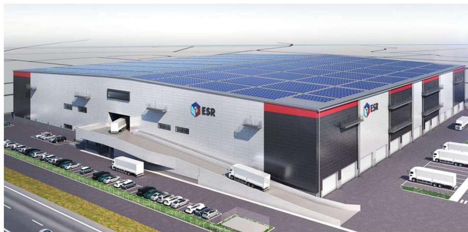
九州の東西南北を結ぶ交通結節点で九州の物流の要所である「鳥栖JCT」付近に位置し、九州全域への配送を網羅。スロープで2階まで直接アクセスでき、1階は建物両面にトラックバースを配置し、2階は天候に左右されることなく入出庫が可能な中央車路式を採用。倉庫部分は、多種多様なオペレーションに対応できる汎用性の多い計画とする。また、環境負荷低減に配慮しCASBEEAランク評価基準を満たす建築計画を実施。
