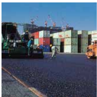
開粒度アスファルト混合物の施工
