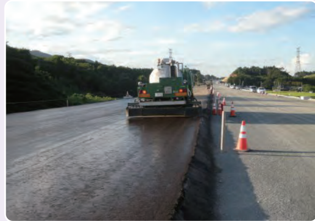
▲右側がペネプライマーを 散布した路盤
