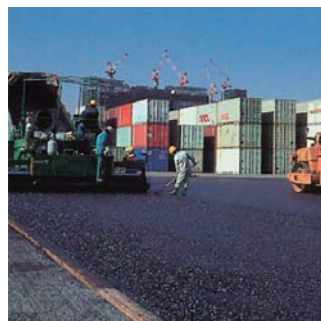
開粒度アスファルト混合物の施工
