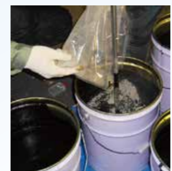
砂・石粉、硬化材の添加・混合
