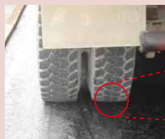
▲ノンスティックゾルの状況
