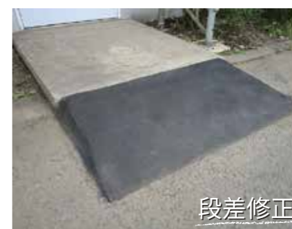
擦り付け合材の 飛散防止
