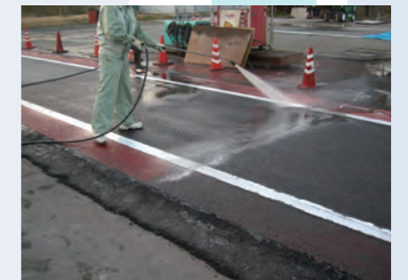
高圧洗浄機による余剰グラウトの除去状況▲
