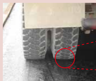
▲ノンスティックゾルの状況
