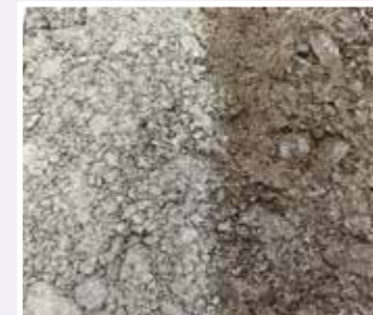
▲右側がペネプライマーを 散布した路盤
