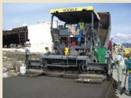
敷きならし状況 (人力施工も可能)
