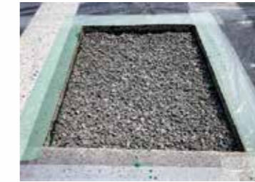
② 母体骨材の敷設
