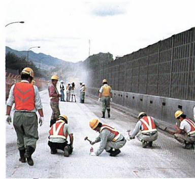
たたき点検 (凹凸面の確認)
