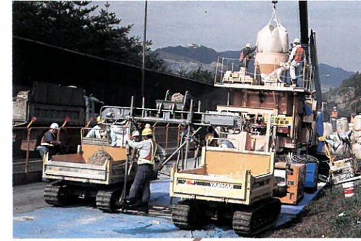
超速硬 SFコンクリート の製造
