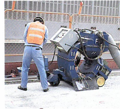
ショットプラスト 研掃 型枠・レール設置
