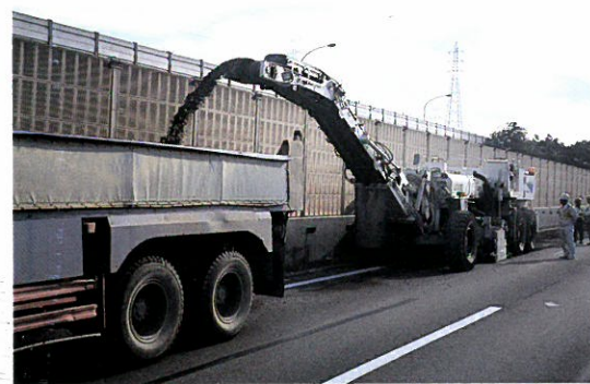
アスファルト 舗装切削機
