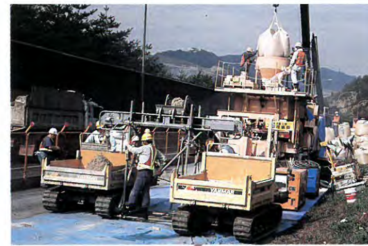
超速硬 SFコンクリート の製造
