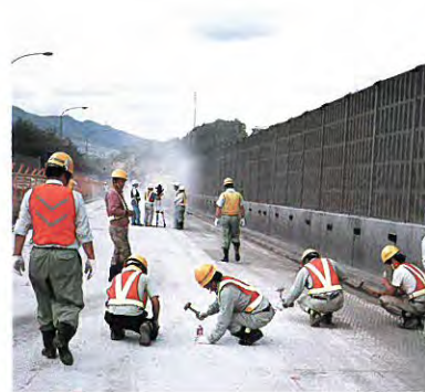
たたき点検 (はく面の確認)
