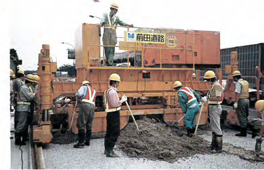
超速硬 SFコンクリート の打設
