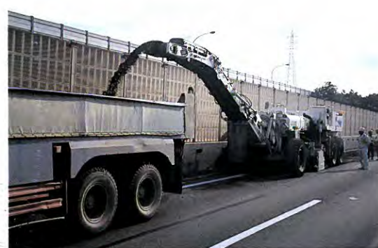
舗装切削 アスファルト
