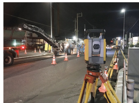
路面切削状況
