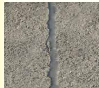
コンクリート舗装の目地補修 (グレー)
