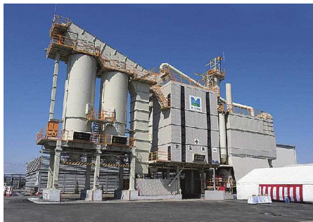
完成した新アスファルトプラント
