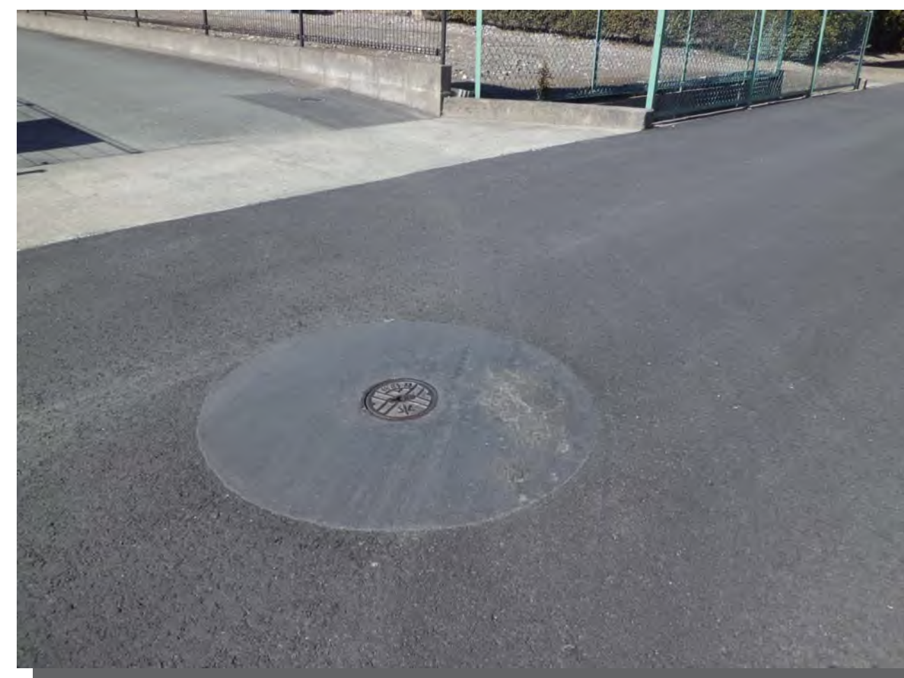
⑤ マンホール周りの段差修正
