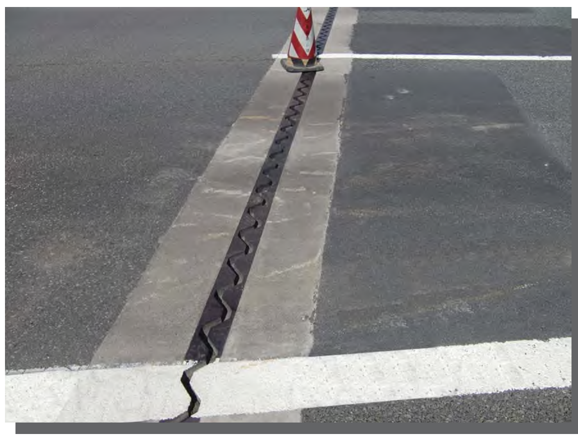
① ジョイント部の段差修正
