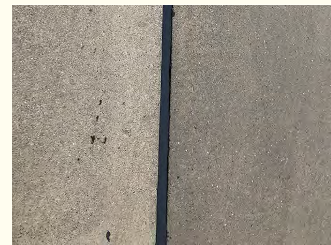
コンクリート舗装の目地補修
