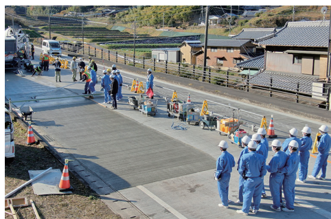
コンクリート舗装を体験した (前田道路四国支店提供)
