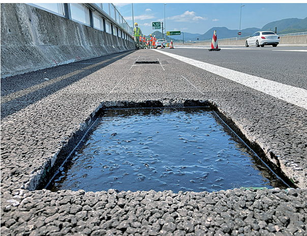
マイルドグースの施工現場(報道発表資料から)
