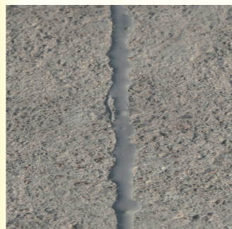
コンクリート舗装の目地補修
