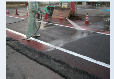
高圧洗浄機による余剰グラウトの除去状況▲
