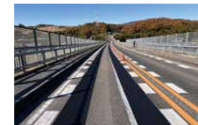
(施工例：タイヤ通行部のみ)
