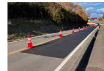
(施工例：車線全体)
