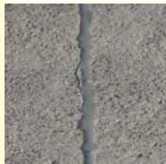
コンクリート舗装の目地補修
