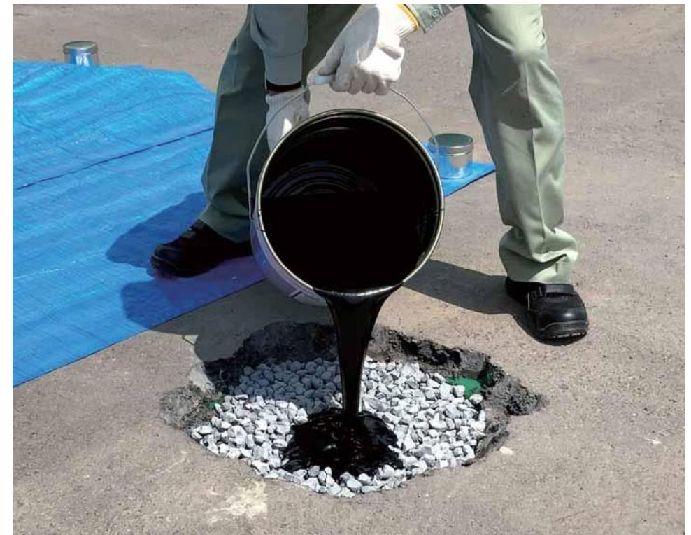
常温で流しこみ施工が可能なスラリー状のアスファルト混合物を、単粒度の粗骨材の間隙に充填する
