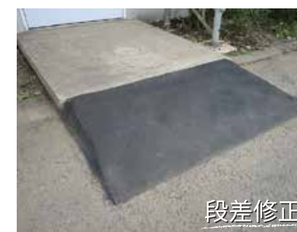
擦り付け合材の 飛散防止
