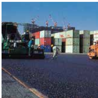
開粒度アスファルト混合物の施工
