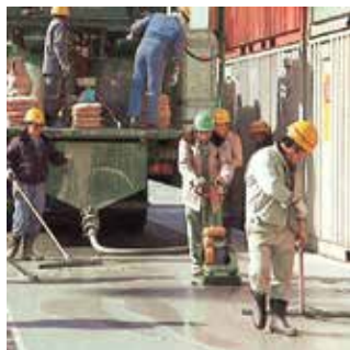
ベアコートミルクの浸透作業
