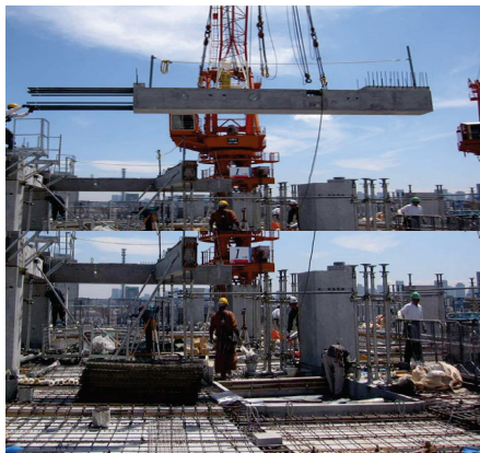
超高層住宅のプレキャスト化急速施工
