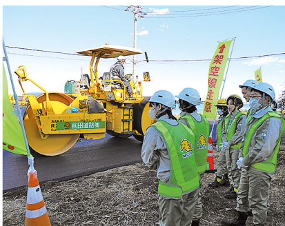
転圧作業を見学する参加者
