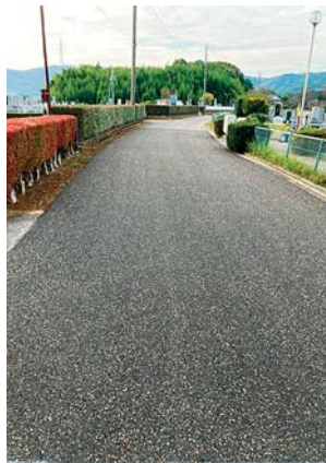
土浦市内の施工箇所の様子
