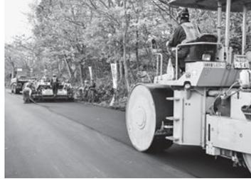
オートド(泡化)養生剤を添加し微細な泡養生をさせることで、アスファルトの粘着性を向上させ、混合性を向上させる中温化アスファルト混合物、施工性はアスファルト、中に分散した微細な泡の潤滑効果により良好な施工性が得られる。養生期間は短縮して、冬期は凍結防止効果が期待できる。前田道路では、LEABを、道内7工場で出荷製造できる体制を整備している。
